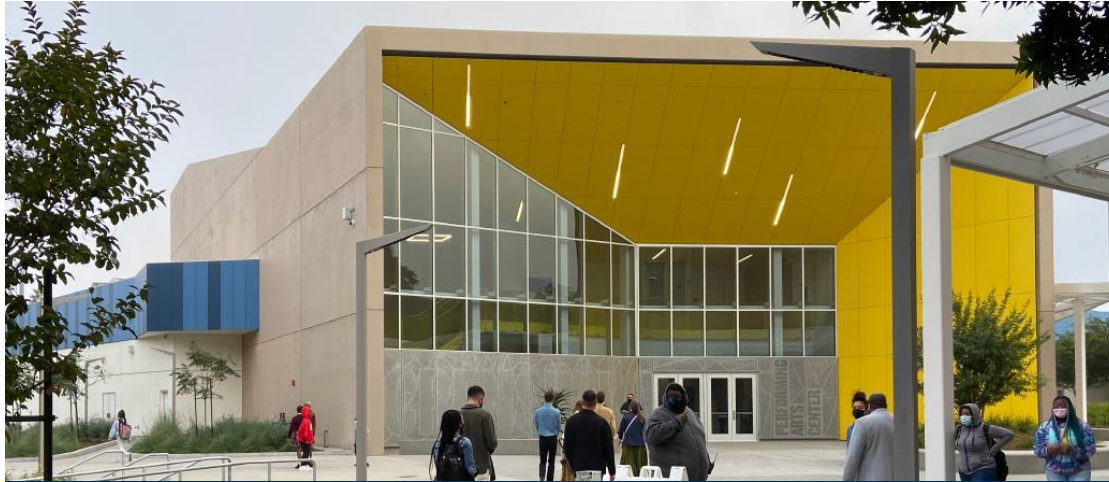
Proyecto de Modernización Sísmica en la Escuela Crenshaw HS
